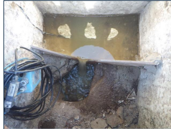
Seuil déversoir triangulaire
