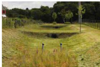
Exemple d'une noue de grande capacité
