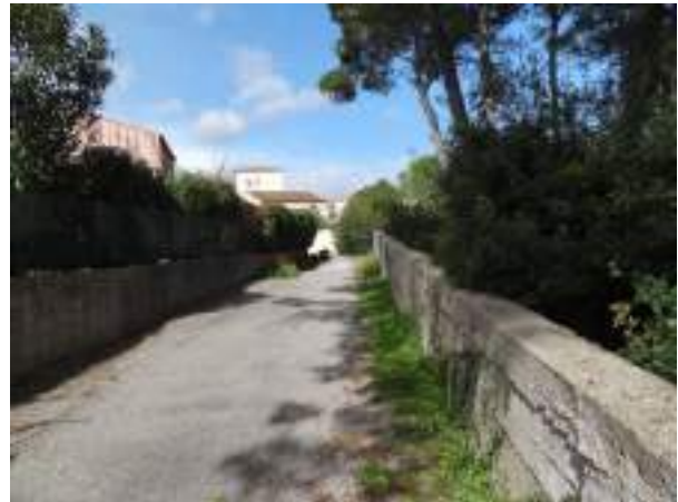
Nord du site – limite du bâti existant
