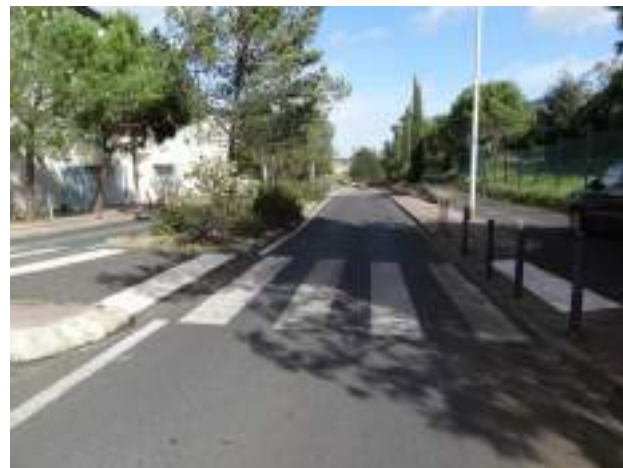
Avenue de Rome au Nord du site
